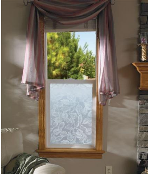
د: استخدام الزجاج الثابت وشبه الشفاف في الجزء السفلي من النافذة
