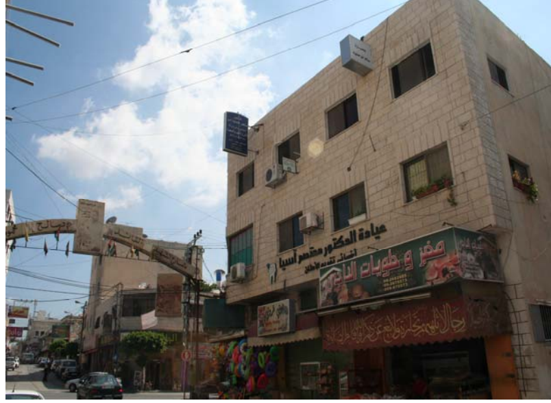
صورة (6): زرع أجهزة التكيف في الواجهات
