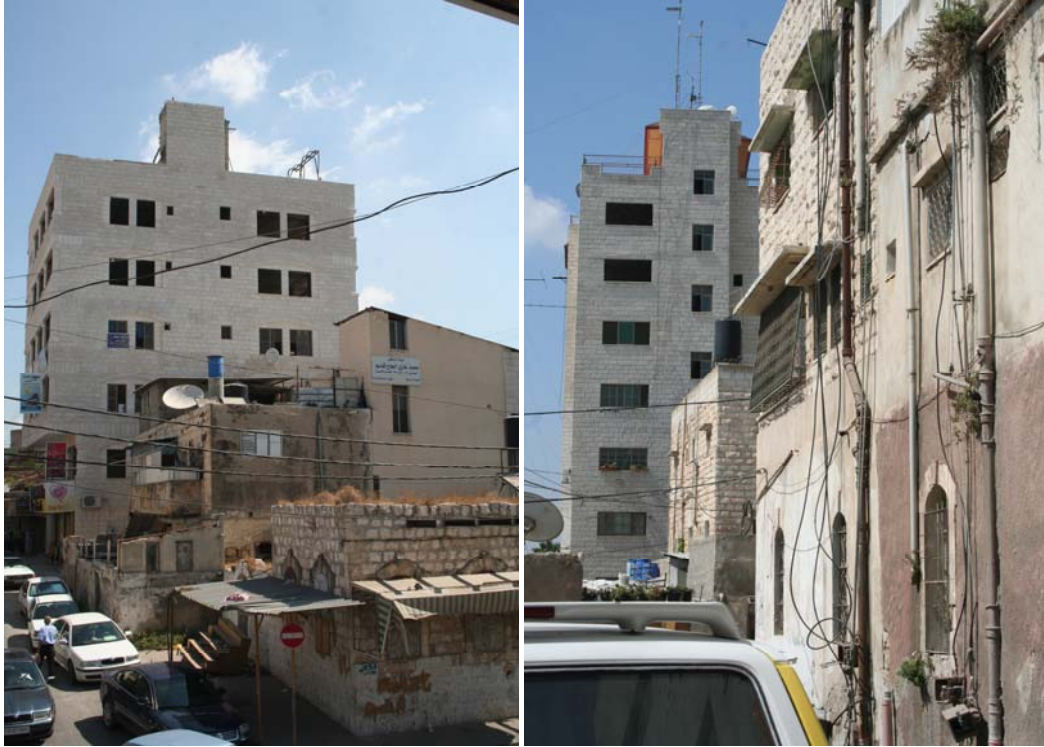
صورة (2): سوء التخطيط العمراني لبعض الأبنية في وسط مدينة طولكرم
