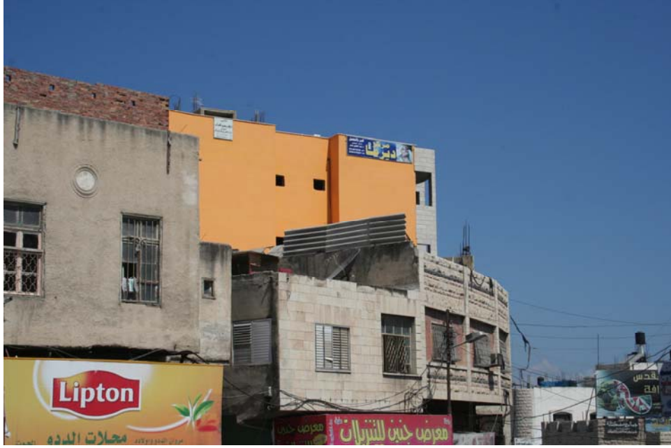
صورة (5): اختلاف دهان واجهات المباني، وعدم تناسقها
