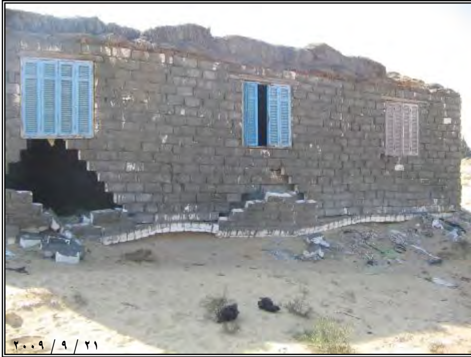
صورة (٢) هدم المنازل نتيجة حركة الرمال بمنطقة قلابشو في نطاق جمعية ١٥ مايو ، (ناظراً اتجاه الشمال).
