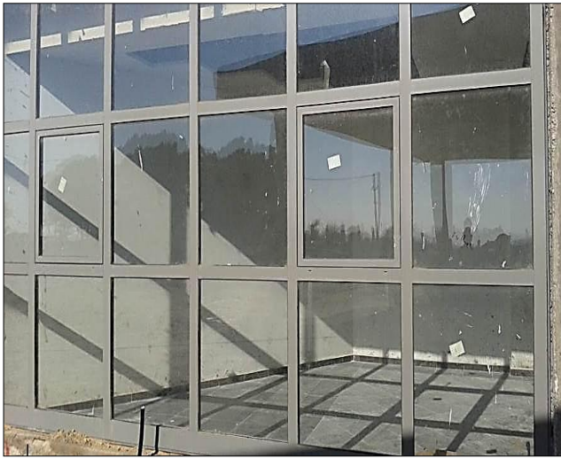
صورة: (4-24) واجهة زجاجية زجاج شفاف مزدوج لإدخال الانارة لممر طويل المستشفى التركي، غزة. المصدر: الباحث.
