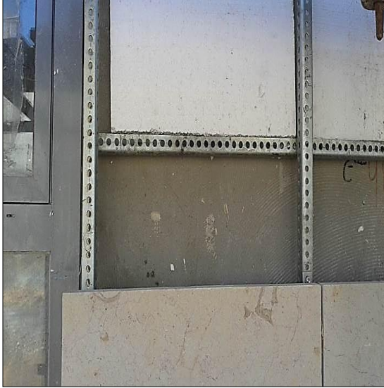
صورة: (4-13) طريقة تثبيت الواح العزل البولستيرين المصدر: تصوير الباحث - غزة
