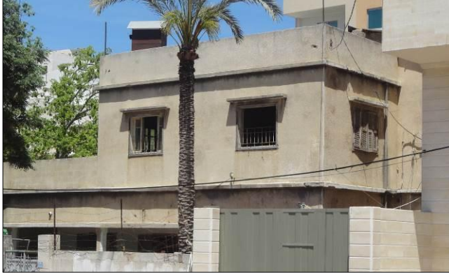
صورة (1-5): مبنى خرساني منذ عهد الادارة المصرية لغزة المصدر: تصوير الباحث - غزة
