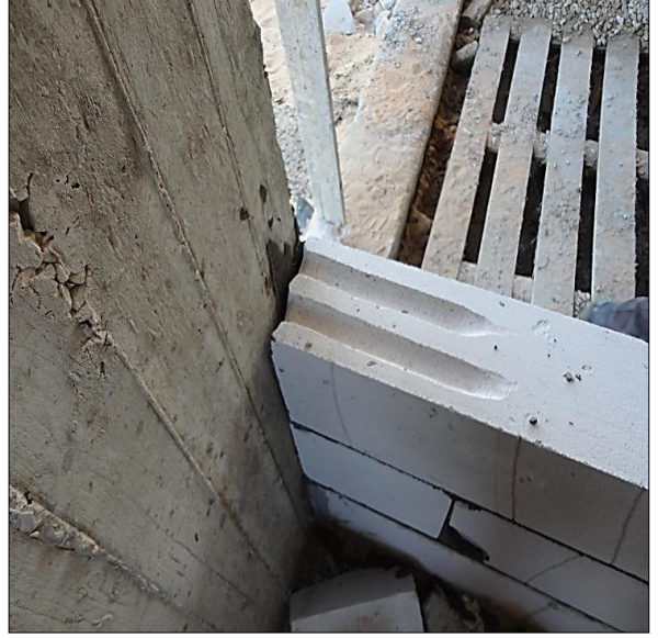
صورة: (4-4) استخدام اسياخ الحديد لتثبيت الحوائط بالأعمدة أو ببعضها البعض... المصدر: تصوير الباحث - تركيا
