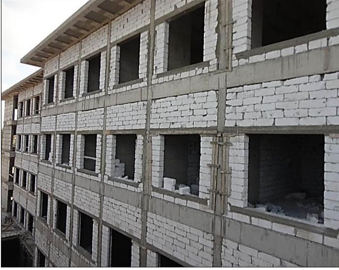
صورة (4-6): عمل أحزمة خرسانية فوق الشبائيك في المستشفى التركي. المصدر: تصوير الباحث - تركيا
