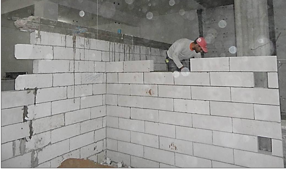
صورة (4-3) بناء القواطع الداخلية والخارجية من بلوك الاليتونج المصدر: تصوير الباحث - المستشفى التركي الفلسطيني- غزة
