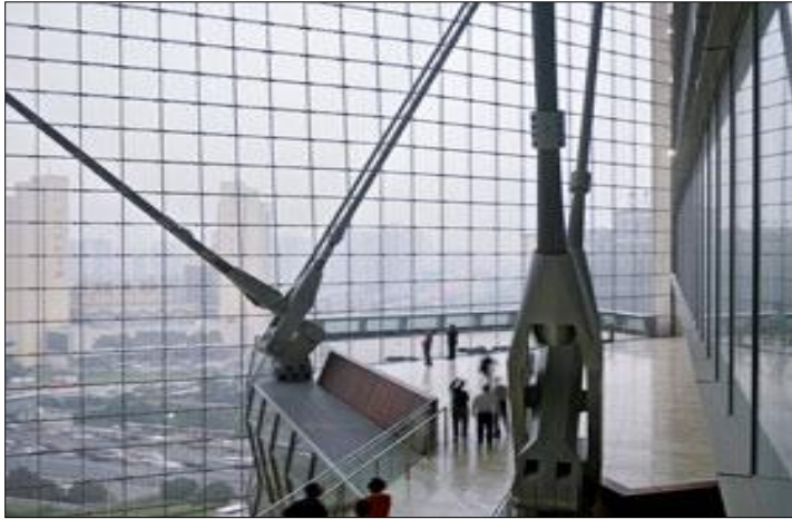
صورة (2-7): الجرأة في تثبيت الواجهة الزجاجية بمرابط ضخمة
