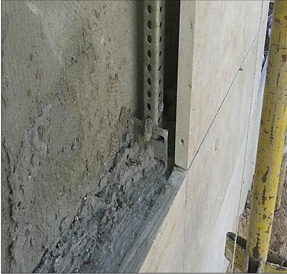
صورة: (4-10) طريقة تثبيت الحجر على بداية الوجهه من أسفل بالخرسانة. المصدر: تصوير الباحث - غزة
