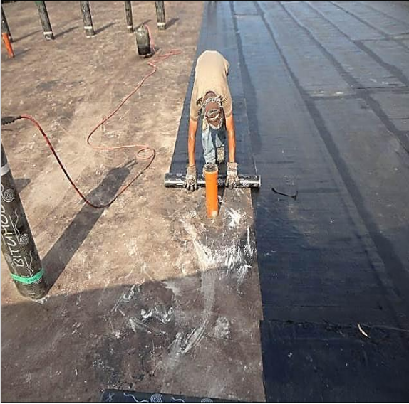
صورة: (4-29) الطبقة الخامسة لفائف عزل بوليبيد المستشفى التركي، غزة المصدر: تصوير الباحث
