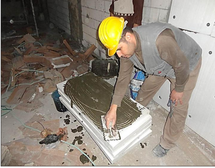
صورة: (4-34) تثبيت اللاصق الاسمنتي على الواح البوليسترين (الكلكل المستشفى التركي، غزة المصدر: تصوير الباحث .
