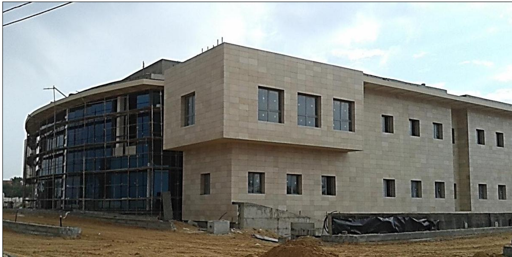
صورة : (4-8) واجهة جنوبية للمستشفى من حجر صخري مثبت ميكانيكيا المصدر: تصوير الباحث - غزة
