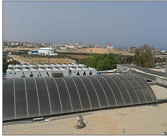
صورة: (4-4) تغطية الفناء في الغلاف الخارجي المصدر: الباحث للمبنى.
