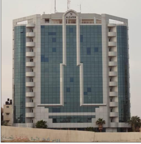
صورة (1-7): مبنى برج الظافر واجهات المنيوم. المصدر: تصوير الباحث-غزة
