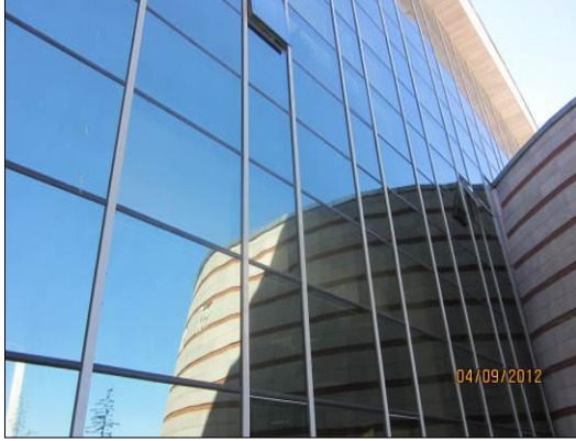
صورة (2-4): استخدام الزجاج المقوى بالحرارة في الواجهه. المصدر: تصوره الباحثة - تركيا
