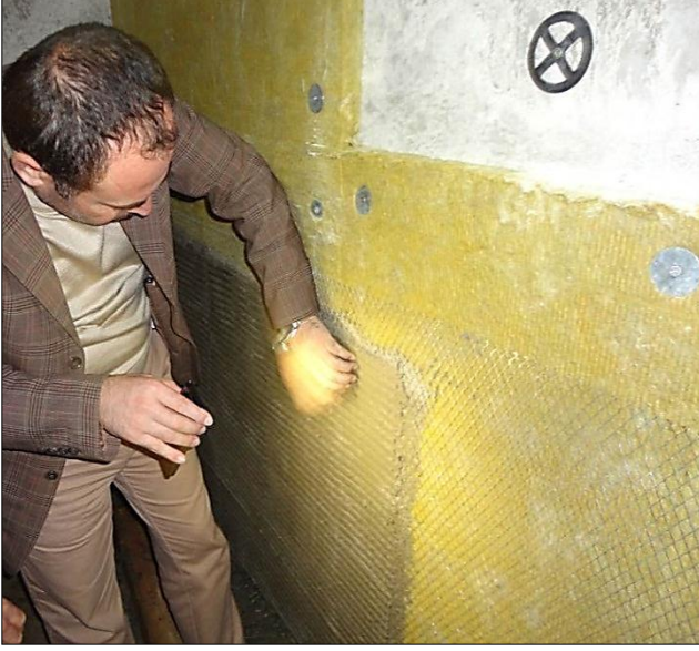
صورة: (37-4) تثبيت الواح الصوف الصخري على الحائط المستشفى التركي، غزة المصدر: الباحث .
