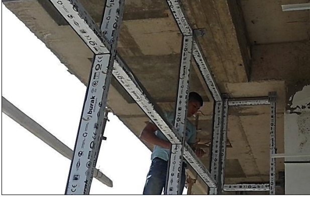
صورة: (17-4) شبابيك الالمنيوم المصدر: تصوير الباحث - غزة
