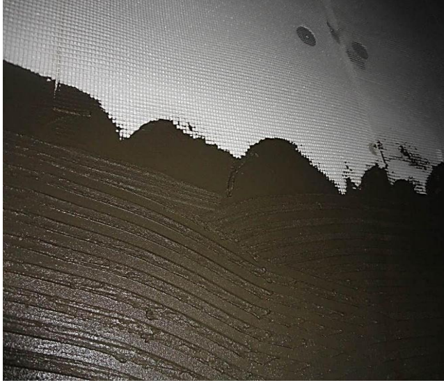
صورة: (4-35) تثبيت شبك الفيبرجلاس على الواح الكلكل وعليه اللاصق الاسمنتي، المستشفى التركي، غزة.
