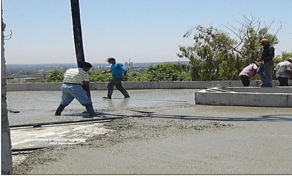
صورة: (4-33) الطبقة السابعة طبقة خرسانة ميول ناعمة المستشفى التركي، غزة. المصدر: تصوير الباحث .
