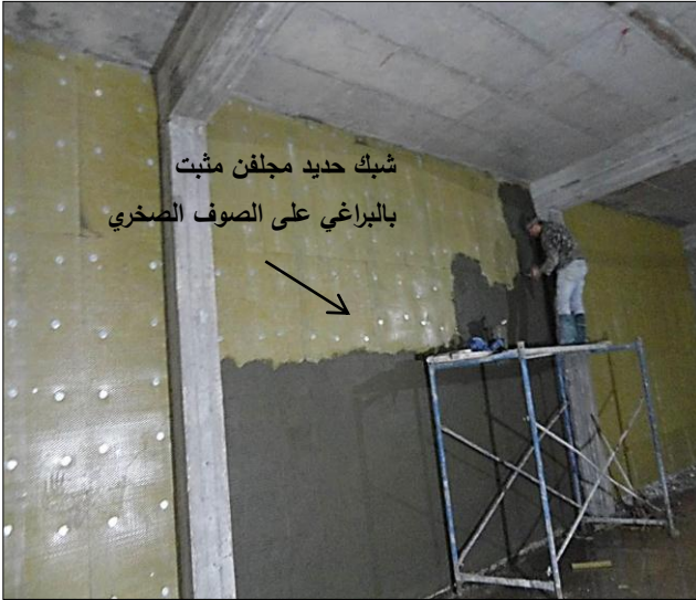
صورة: (38-4) طبقة اللاصق الاسمنتي على شبك الحديد المستشفى التركي، غزة المصدر: تصوير الباحث .
