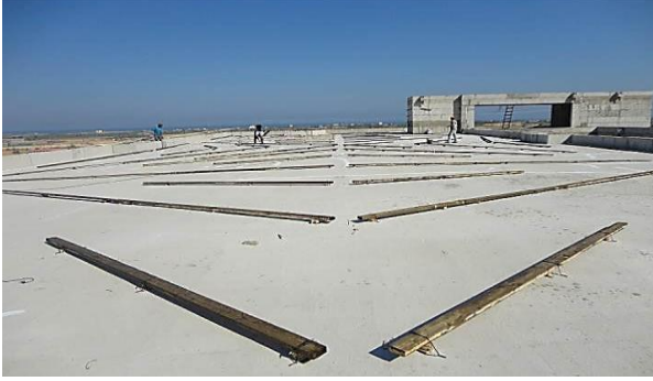
شكل: (4-19) شبلونة تحديد ميول طبقة الخرسانة على مصارف المياه، المستشفى التركي، غزة المصدر: الباحث
