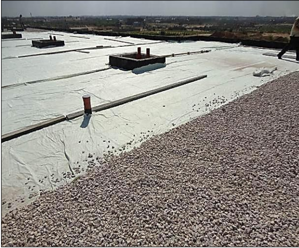
صورة: (27-4) الطبقة الثالثة من قماش من Geotic style المستشفى التركي. غزة. المصدر: تصوير الباحث
