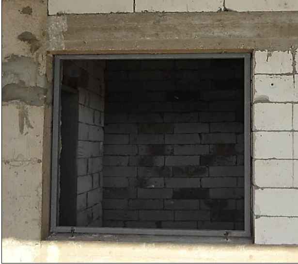
صورة: (4-15) تثبيت إطار الشباك على بروفيل الحديد المصدر: تصوير الباحث - غزة
