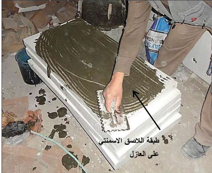
صورة: (4-4) عمل طبقة من اللاصق الاسمنتي على لوح البوليسترين المصدر: الباحث .
