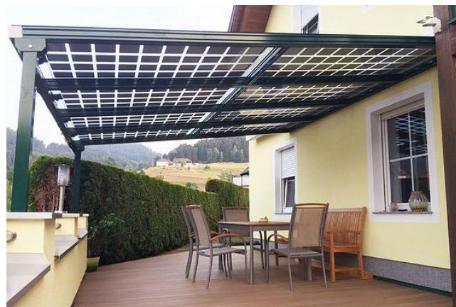
شكل (2.13): استخدام الوحدات الكهروضوئية كمظلات للتراسات والبلكونات
