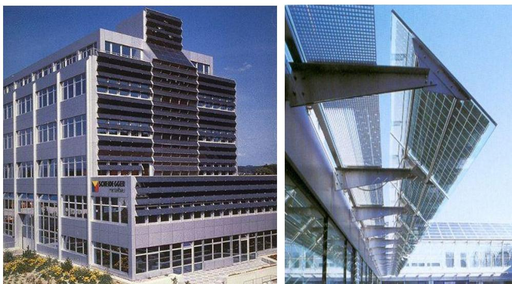
**شكل (2.12): استخدام الوحدات الكهروضوئية ككاسرات شمس كما في مركز شايدجر في السويد**
