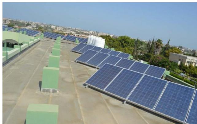
شكل(3.8): أول مشروع لتركيب خلايا كهروضوئية على أسطح مدرسة حسن الأغا لتوليد الكهرباء لكافة مرافق المدرسة
