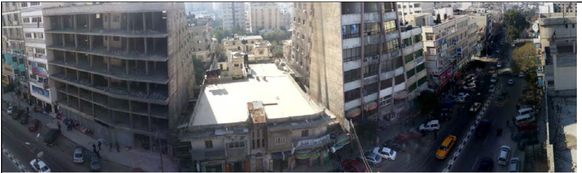
شكل رقم (3-10) صورة توضح غياب الصيانة للمباني بميدان الجندي المجهول بمدينة غزة. المصدر الباحث
