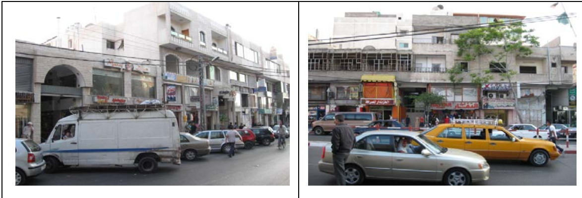
شكل رقم (4-12) عدم توحيد ارتفاعات الأدوار. المصدر (الباحث)
