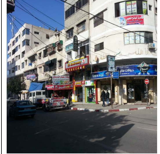
شكل رقم (2-2) واجهات المباني بميدان الجندي المجهول. المصدر (الباحث)
