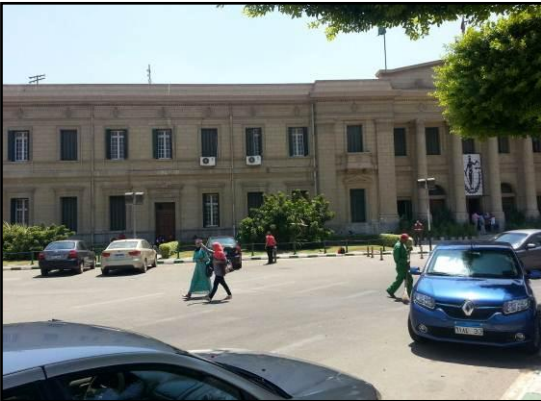
صورة (2-10) فراغ مشترك للمشاة والمركبات بجامعة القاهرة المصدر: الباحث
