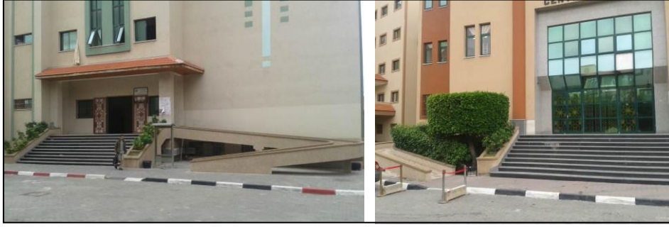
صورة (4-22) توضح ادراج ومنحدرات بعض المباني المصدر: الباحث
