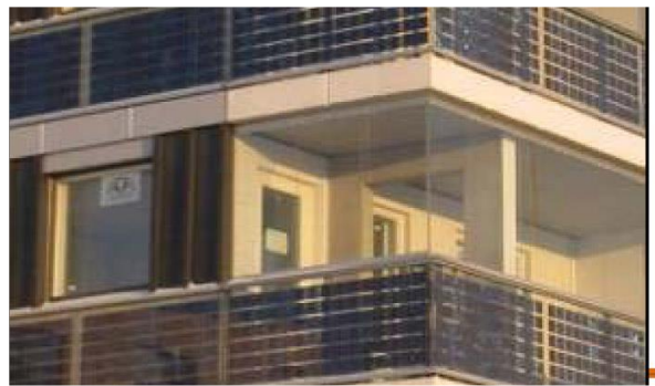
شكل (4-18) خلايا شمسية كدريزين البلكنات والتراسات (Krawietz, 2011)
