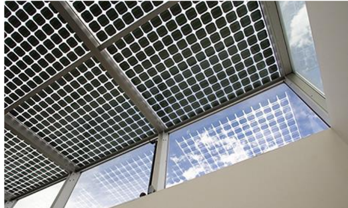
شكل (4-4) استخدام الخلايا الشمسية كأسطح شفافة (2010, Sigulda, Latvia)
