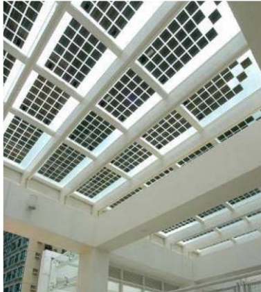
شكل (4-4) استخدام الخلايا الشمسية كأسطح شفافة (2010, Sigulda, Latvia)
