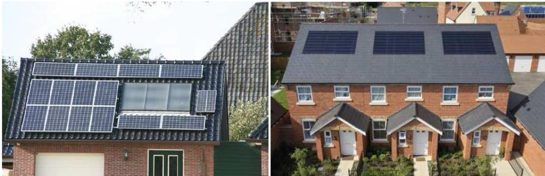
شكل (4-6) الخلايا الشمسية فوق مواد الإنهاء التقليدية في الأسطح المائلة (Sinaps, Donker, 2013)
