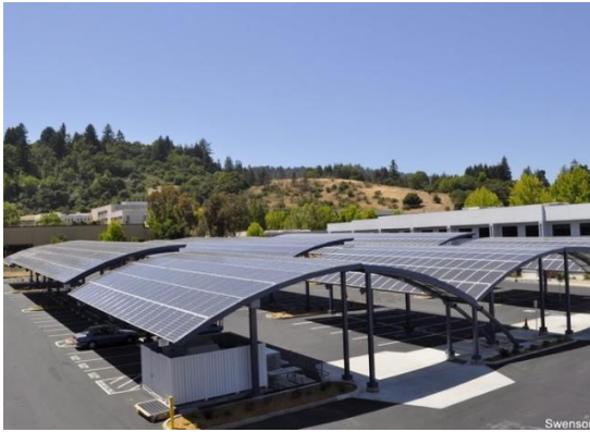
شكل (4-10) الخلايا الشمسية الرقيقة والمرنة واستخدامها في الأسطح المنحنية (Wesoff, 2011)
