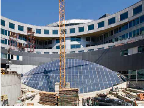
شكل (4-14) واجهات خلايا شمسية بجدران مائلة (Krawietz, 2011)
