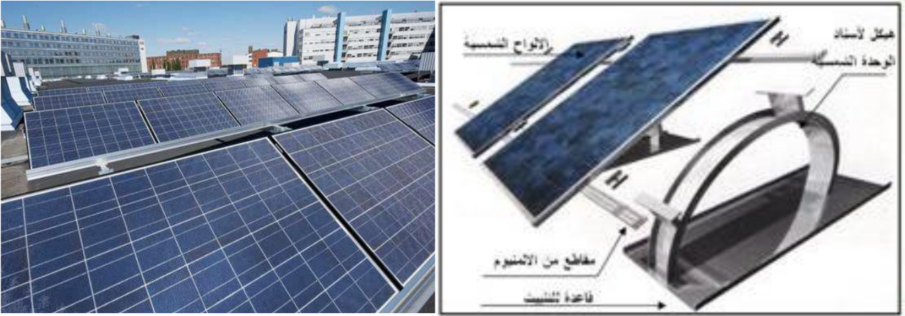
شكل (4-1) الوحدات الشمسية المائلة المصممة للأسطح الأفقية (2010, Sigulda, Latvia)
