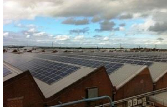
شكل (4-3) الأسطح المسننة وتكاملها مع الخلية الشمسية (2010, Sigulda, Latvia)
