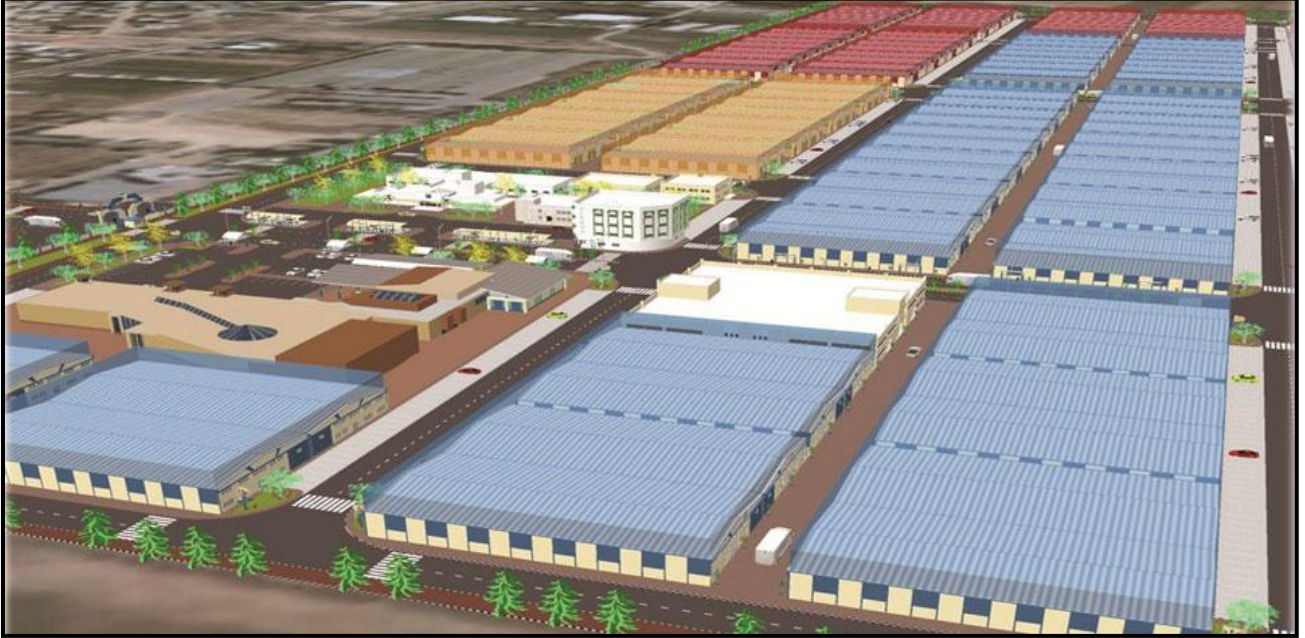
شكل (4-11): منظور للمنشآت والمباني والمصانع المقامة والمقترحة في مدينة غزة الصناعية في مرحلة التصميم المصدر: شركة فلسطين لإنشاء وإدارة المناطق الصناعية، 2015
