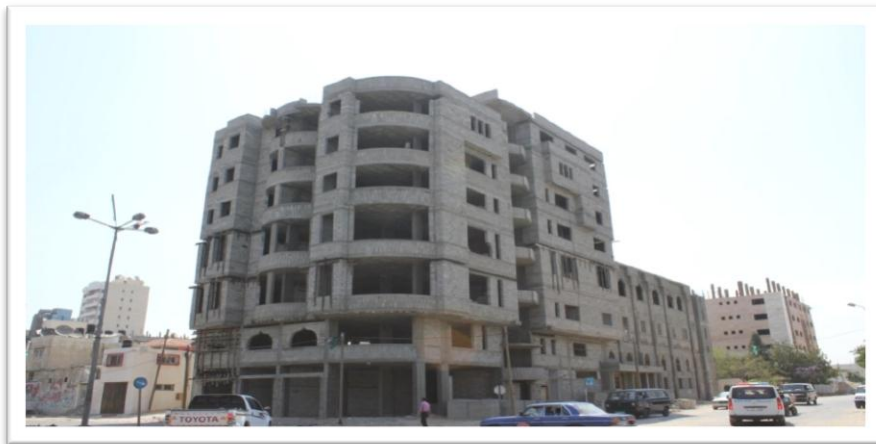
شكل (5.4): مشروع إنشاء مبنى البلدية الاستثماري المصدر : بلدية غزة
