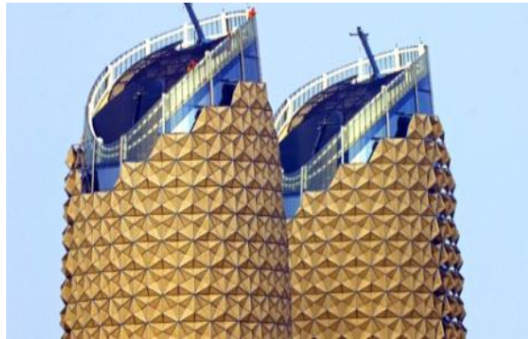
شكل (4.25): الخلايا الكهروضوئية المستخدمة لتوليد الطاقة المصدر: (Laylin, 2014)
