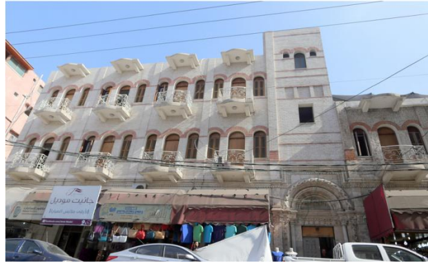
شكل (5.3): مبنى بلدية غزة بعد الترميم
