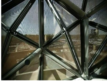
شكل (4.24): الألياف الزجاجية المستخدمة في الواجهة الخارجية للمبنى المصدر: (Voitstudios,2017)
