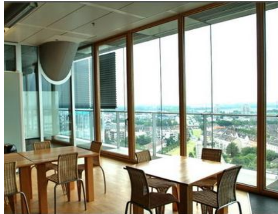
شكل (4.9): الستائر المعدنية في المبنى واستجابتها لأشعة الشمس
