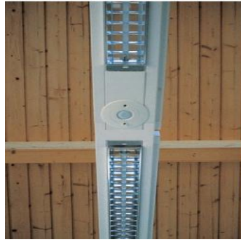
شكل (4.3): أجهزة الاستشعار بين وحدات الانارة الفلورسنتية
