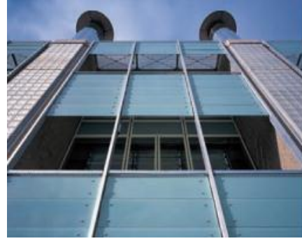
شكل (4.6): نظام التظليل الخارجي في حالة الشمس والظل
