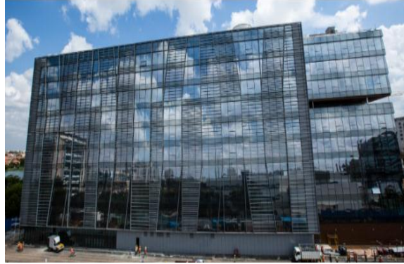
شكل (4.36): مبنى Intel Mobile Communication India - الهند المصدر: (Khandavilli, 2017)
