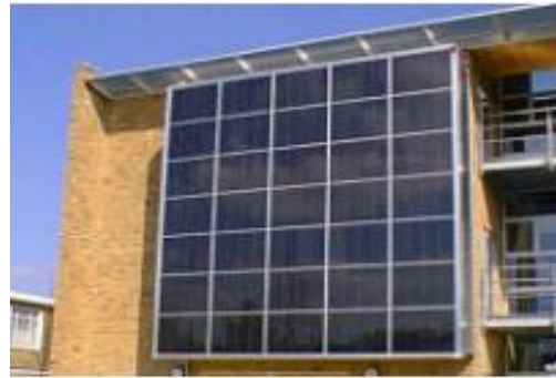
شكل (4.5): الخلايا الكهروضوئية في الواجهة الجنوبية المصدر: (Bre Project,2017)
