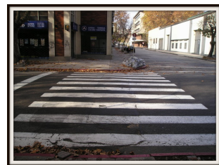
Paso Peatonal (Pasos Peatonales)
