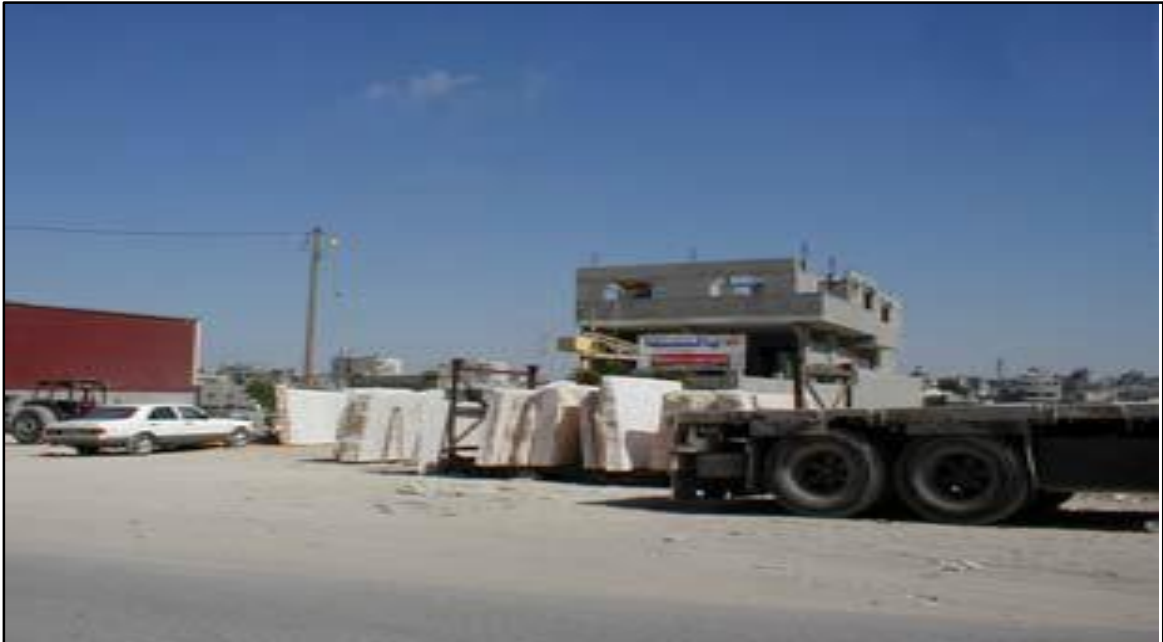
شكل (3.7): استعمال المبنى (مصنع رخام) مخالف للاستعمال السكني للمنطقة
