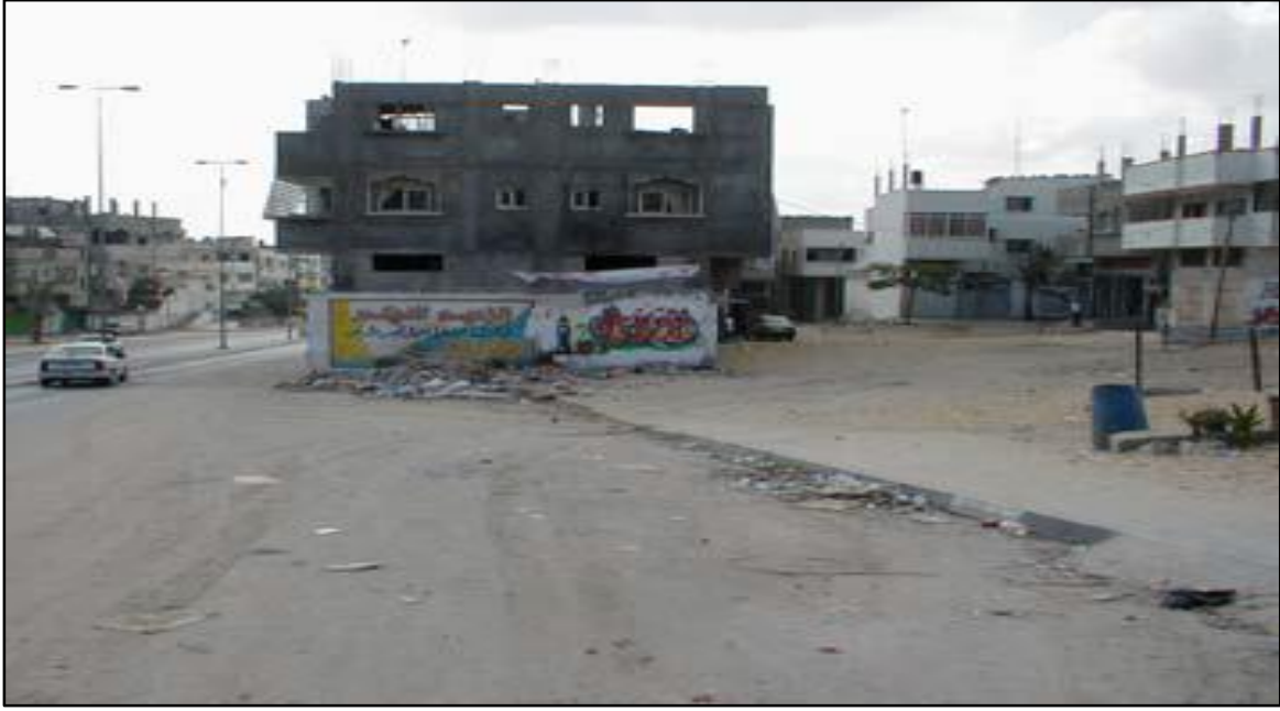
شكل (3.6): المبنى متعدي على خط تنظيم الشارع
