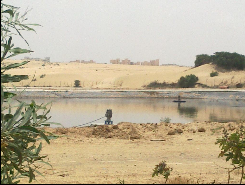
شكل (2-18) أحواض معالجة المياه العادمة غرب مدينة خانيونس المصدر: زيارة ميدانية قام بها الطالب لمنطقة الدراسة بتاريخ 2012/5/1م.
