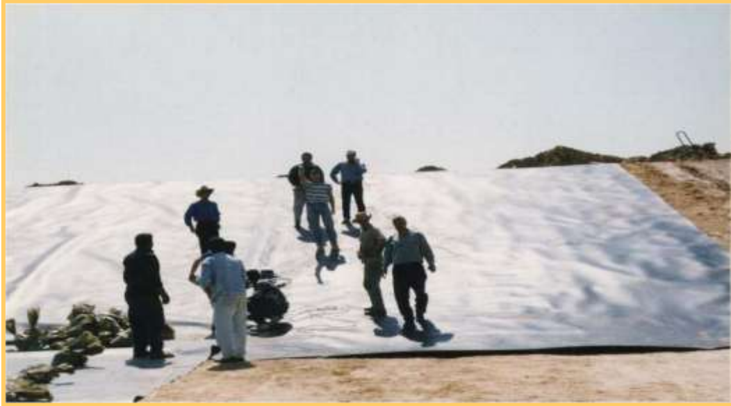
شكل (3.17) إضافة طبقة عازلة من رقائق البولي إثيلين
