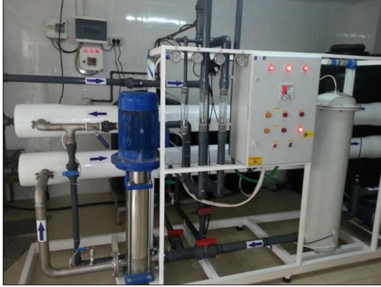
شكل (2-1) طريقة التناضح العكسي لإحدى محطات التحلية في قطاع غزة.
