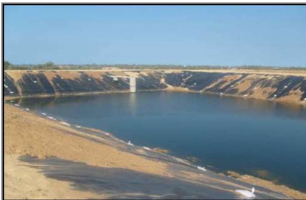
صورة (5-2) حوض المعالجة اللاهوائية في أحواض معالجة المياه العادمة خانيونس.
