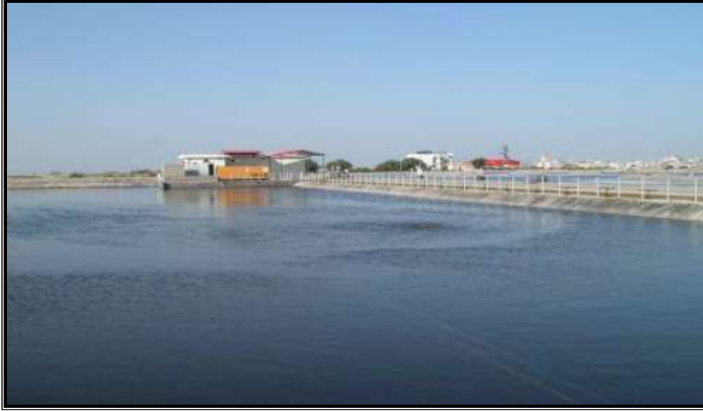
صورة (2-2) أحواض المعالجة اللاهوائية في محطة الشيخ عجلين.
