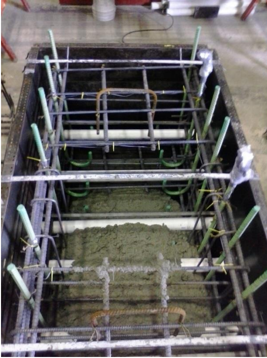
Figure 23. Pile cap rebar, formwork and pour
