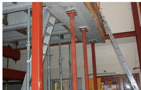
(d) Temporary abutment support
