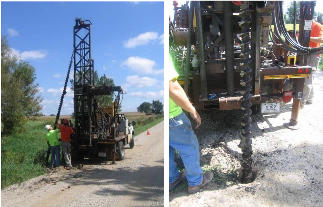
a.) Drilling rig
