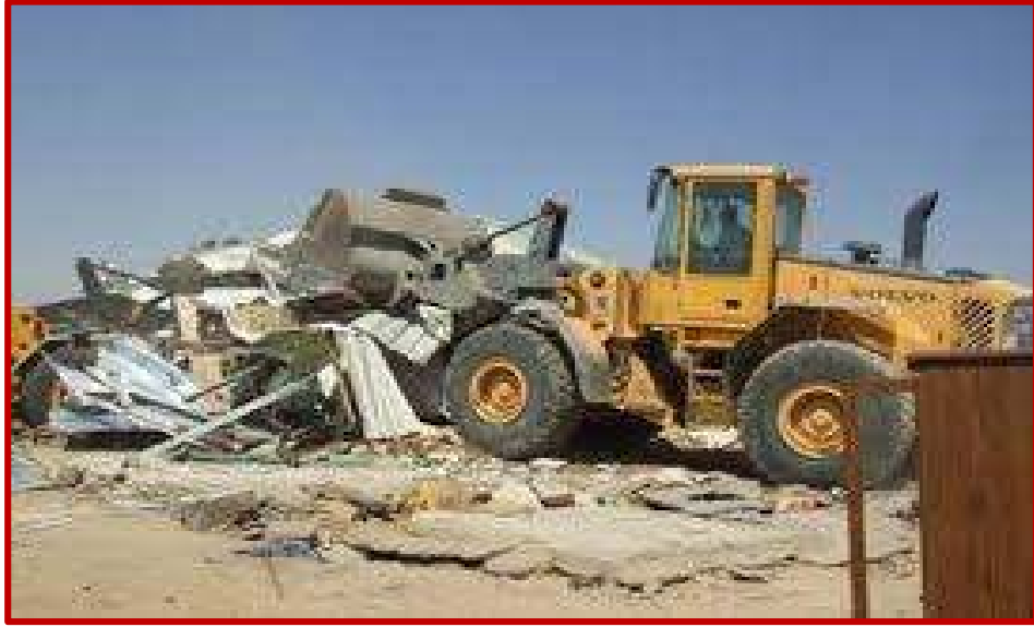
صورة (7): عمليات هدم للمنشآت.
