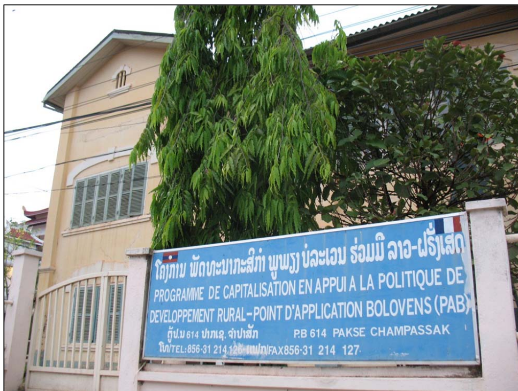
Image 14: Pakxe office headquarters of the Programme de Capitalisation pour l'Appui à la politique de Développement Rural (PCADR) - Point d'Application des Bolovens (PAB). Source: Photograph by author, March 27, 2009.
