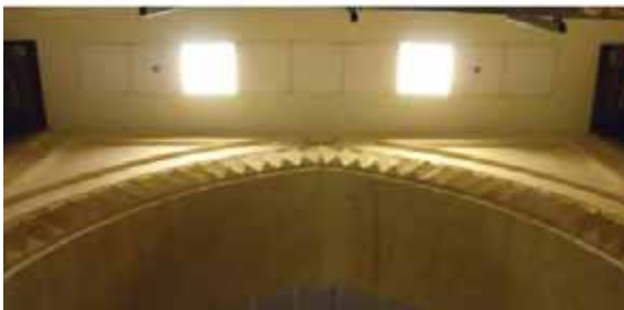
شكل ( 3-78): استخدام وحدات إضاءة ذات أنبعاثات حرارية كبيرة (المصدر: الباحث)
