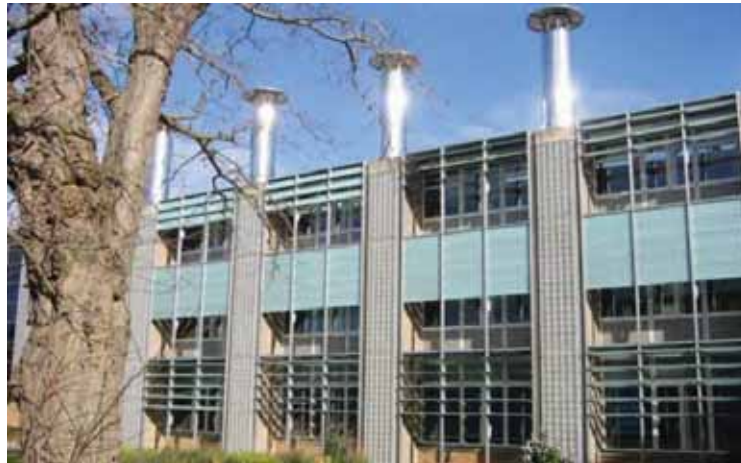
شكل ( ٣-٥٨) : استخدام الطاقة الشمسية وطاقة الرياح في الحصول على الضوء والتهوية الطبيعية المصدر : ( http://projects.bre.co.uk/envbuild/envirbui.pdf )
