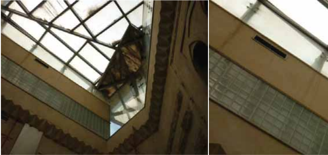
شكل ( ٣-٧٩): عدم استخدام الفتحات السقفية في التخلص من الطاقة الحرارية الزائدة والأعتماد على أنظمة التهوية الصناعية (المصدر: الباحث)
