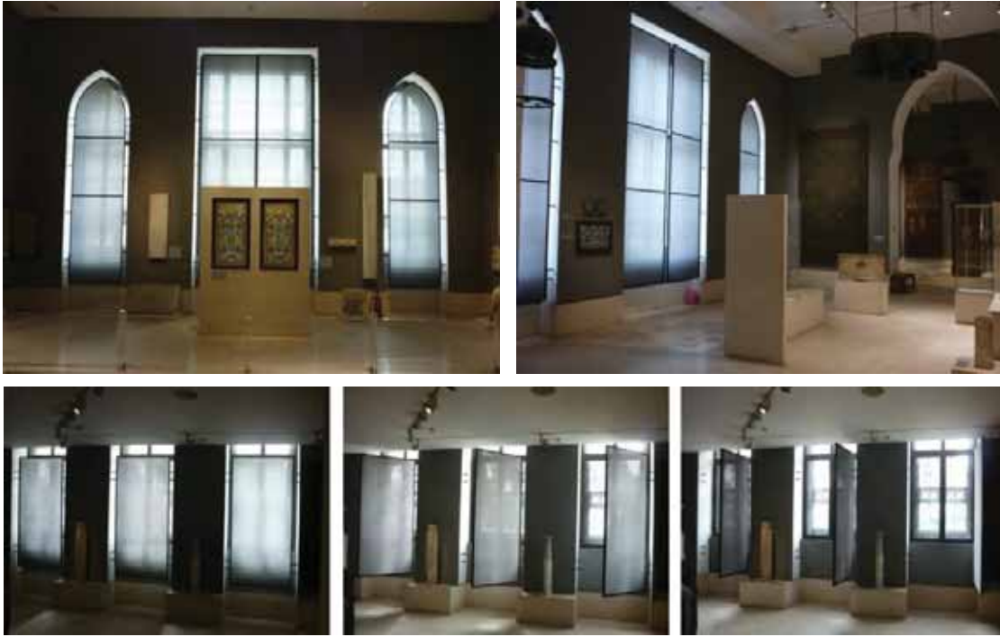
شكل ( ٣-٨٦): أعلى: النوافذ المظلة على الواجهة الخارجية التى تحتوى على وحدات مظلة من الداخل أسفل: مراحل فتح الوحدات المظلة (المصدر:الباحث)
