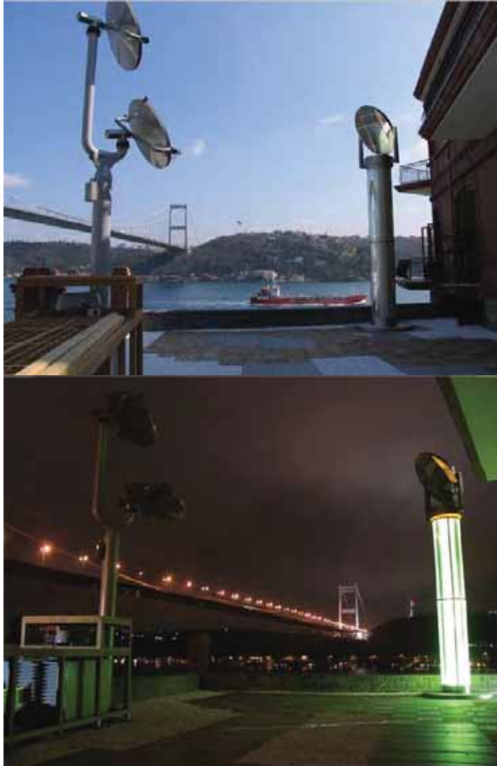
شكل (٣-٢٣): يوضح استخدام الهليوستات يعمل بطريقة (Sun Beam) في فترات مختلفة من ساعات اليوم
