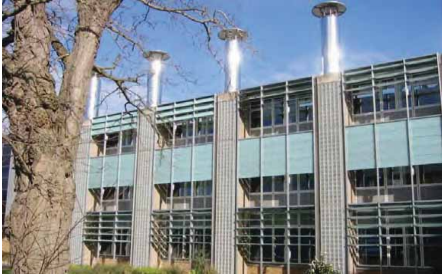
شكل ( ٣ - ٥ ) : أبراج للتهوية (Ventilation towers) على الواجهة الجنوبية
