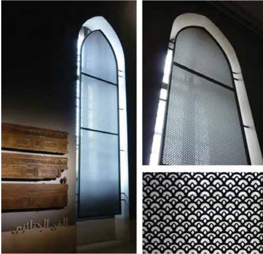
شكل ( ٣-٨٧): الوحدات الداخلية المظله التي تساعد في التقليل من الأشعاع الشمسي الواقع على النوافذ (المصدر: الباحث)
