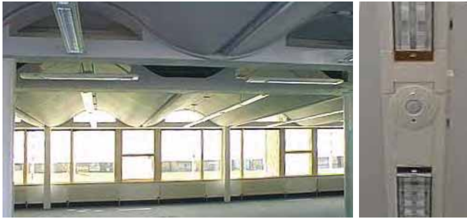
شكل ( ٣-٥١): استخدام تكنولوجيا الخفت (Dimming technology) عن طريق وحدات أضواء مثبت بها حساسات Integral sensors تقوم بقياس نسبة الإضاءة داخل الفراغات (المصدر: Michael Wigginton and Jude Harris, "Intelligent Skins")
