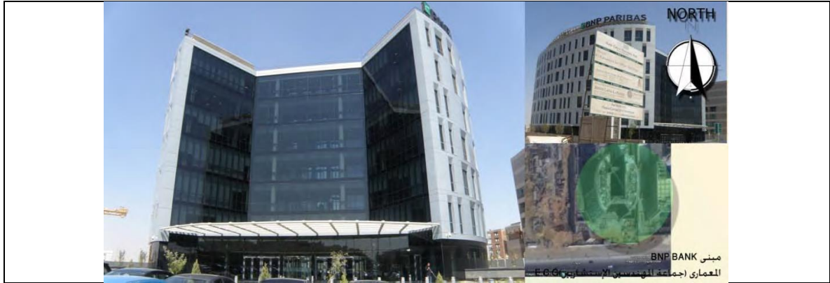
شكل يوضح: مبنى بنك B N P - توجيه الواجهة الزجاجية ناحية الجنوب مع استعمال تكسيات ألواح معدنية (Composite panel) بدون عزل واستعمال مظلة معدنية بكامل عرض المبنى. المصدر: الباحث وخرائط جوجل.
