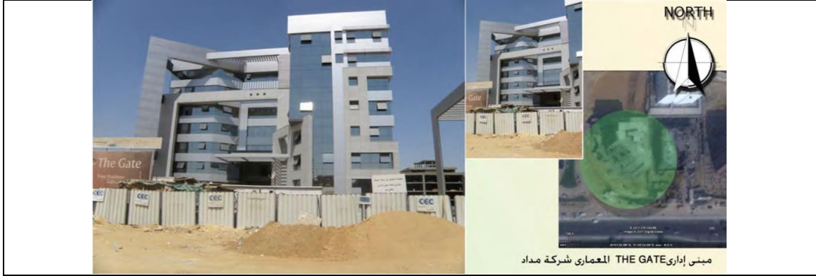
شكل يوضح: مبنى إداري THE GATE - توجيه الواجهة الزجاجية ناحية الجنوب - تكتسيات الواجهة من الأليكووند (الواح الالمنيوم المزدوجة).. المصدر: الباحث وخرائط جوجل.
