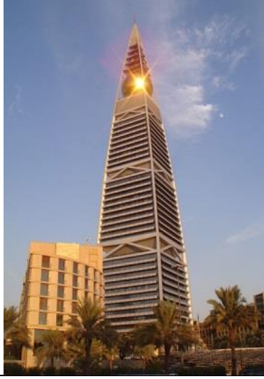
شكل (3.2): مركز الفيصلية - الرياض (1993-2000)، المعماري فوستر وشركاهه. المصدر: أخبار البناء العربي، مشروع سيليكون جيتس، السعودية، يناير - مارس 2007.
