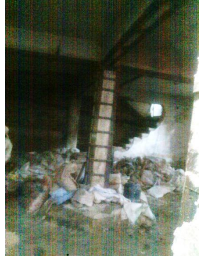
الشكل (37) تدعيم الأعمدة في أحد أقبية المباني
