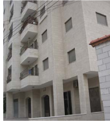
صورة (36): مدخل إحدى العمارات السكنية في منطقة الدراسة المصدر: الباحث.
