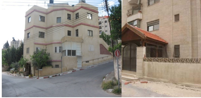
صورة (58): سور مبني من الباطون المسلح والقسارة الخارجية المصدر: الباحث.
