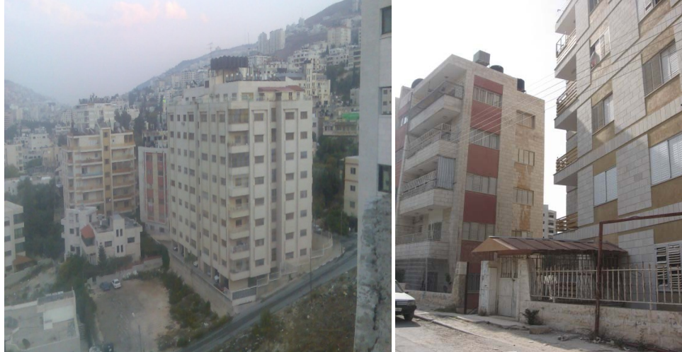
صورة (39): صورة لمنطقة الدراسة يلاحظ من خلالها تفكك النسيج العمراني للحي السكني كنتيجة لتنظيم البناء الحالية المصدر: الباحث.
