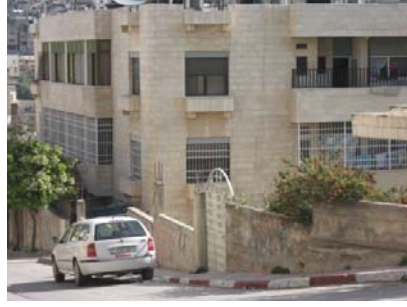
صورة (57): سور مبني من الباطون المسلح المصدر: الباحث.
