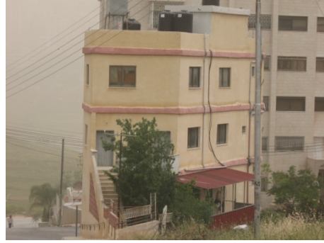
صورة (55): مبنى سكني عائلي كسوته الخارجية من القصارة والدهان المصدر: الباحث.
