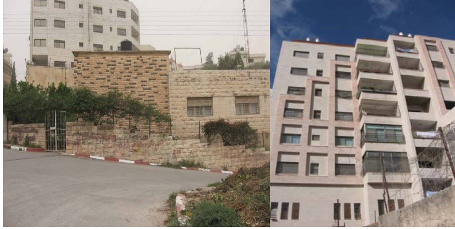
صورة (18): أثر تطبيق المادة 10 على شكل المباني السكنية وإعطاء التنوع الجمالي المصدر: الباحث.
