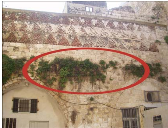
شكل رقم(6.49) نمو النباتات بين مداميك الحجر
