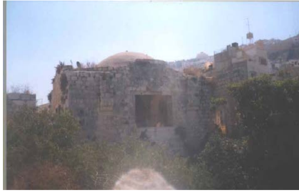
شكل رقم(5.16) ظهور القببة في تسقيف غرفة الحاكم
