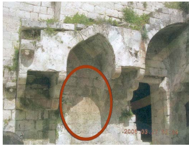
شكل رقم (6.47) تآكل الحجارة في احد أجنحة قصر طوقان
