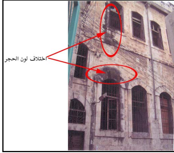
شكل رقم (6.46) اختلاف لون الحجر نتيجة العوامل المناخية
