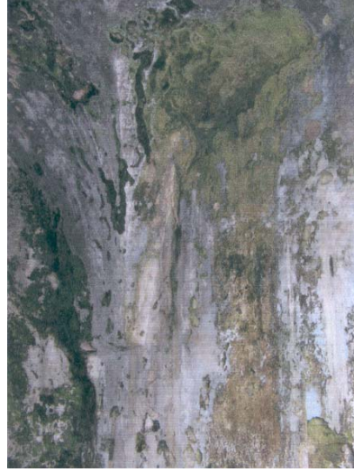
شكل رقم(6.48) نمو الطحالب في جميع أجزاء الغرفة
