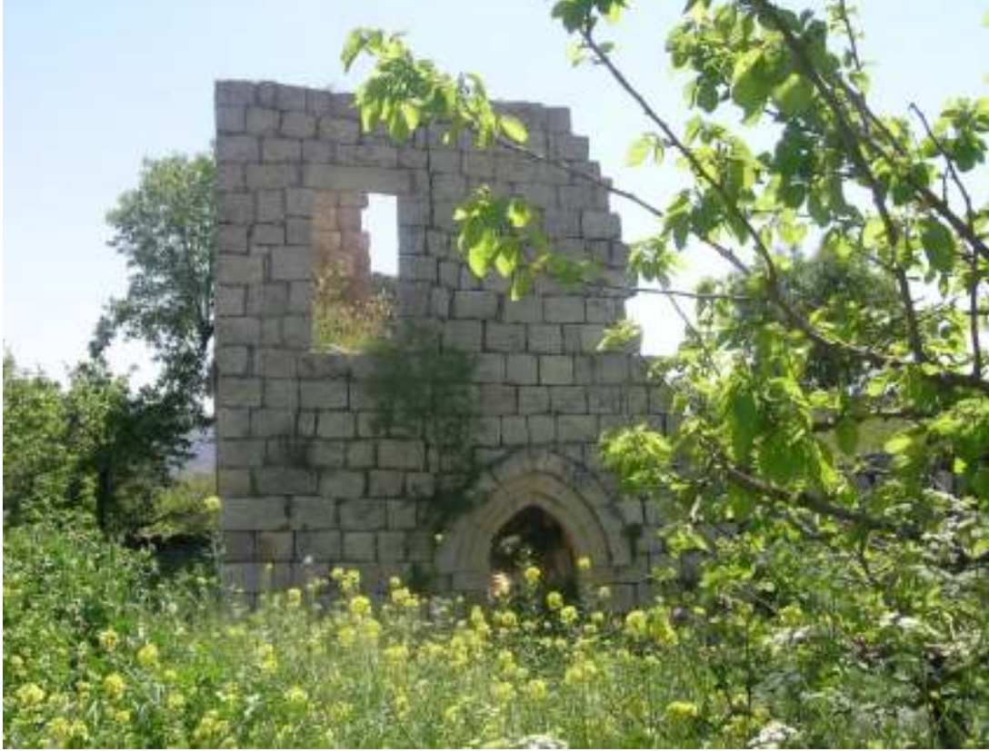
شكل (5): صورة ل احد مباني بيرزيت التاريخية المتهمة. (الباحث، 2012)
