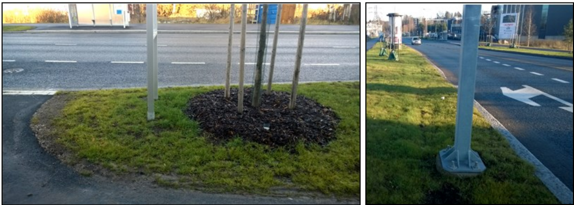
Kuva 40. Viheralueyksikön esittämä huomiokohdat kunnossapidossa. Viheralueella olevien rakenteiden ympärillä tulisi olla vähintään metrin työskentelytila, jotta kunnossapito onnistuu ilman erikoiskoneita
