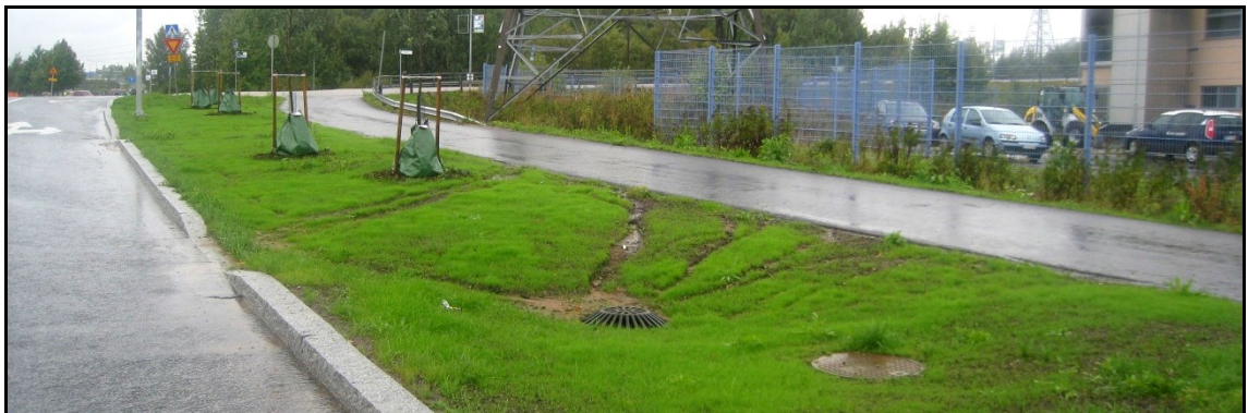
Kuva 38. Huleveden pintavalunnan aiheuttamat vahingot viheralueelle
