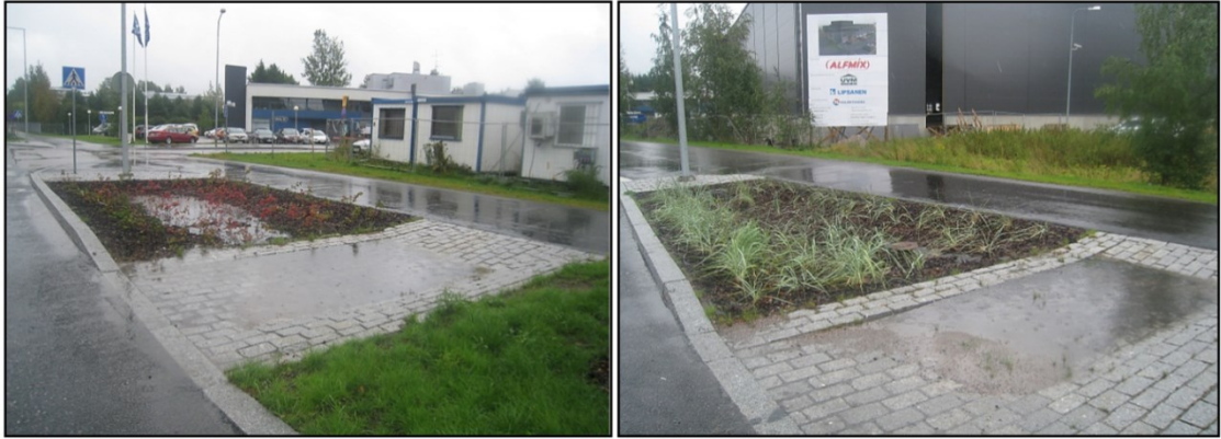
Kuva 35. Kivetyspainanteen laskeutumiskynnys pidättää hulevesiä erittäin tehokkaasti. Samalla roskat kerääntyvät kivetyspainanteelle, mistä ne on helpompi siivota lakaisukoneella.
