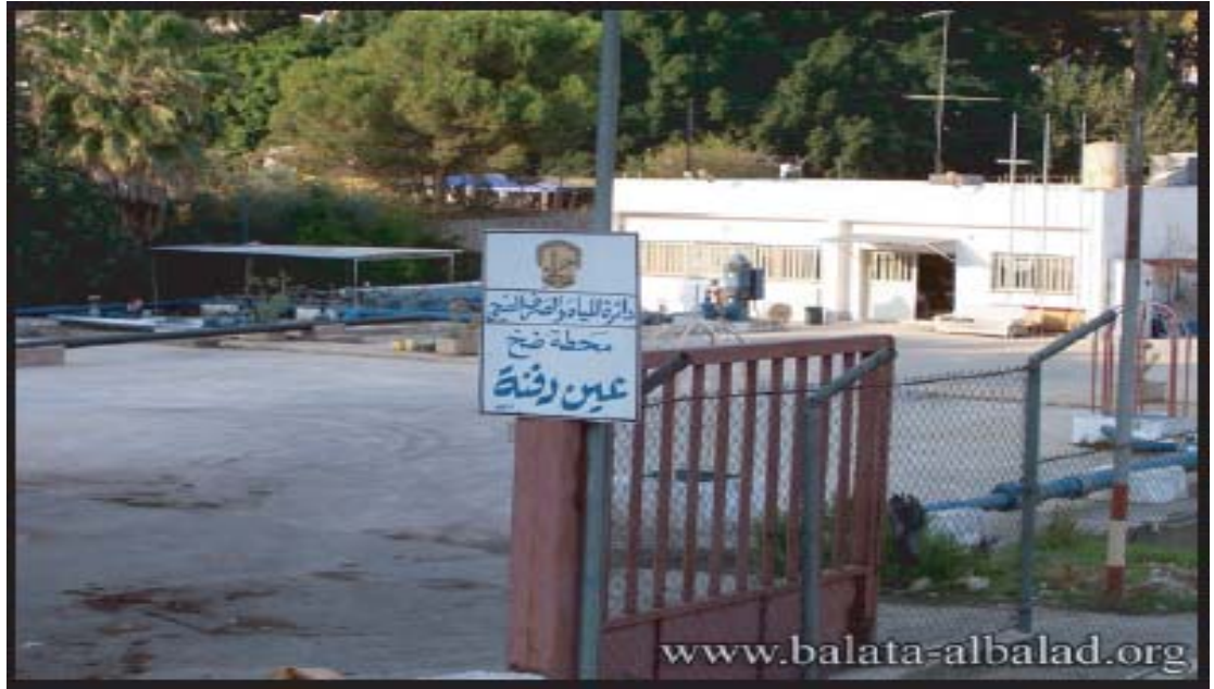
Ein Dafna Pumping Station
