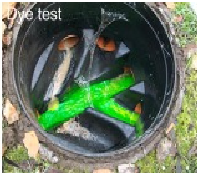
Kuva 4. Kaivosta voidaan selkeästi havaita vihreällä väriaineella värjätyn veden kulkemisreittiä. (Drains IOM).
