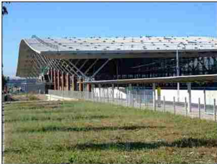
(b) Gare d'Aix-en-Provence TGV, built on the LGV Méditerranée
