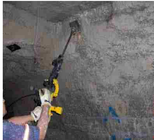
d. Installing a Rockbolt.
