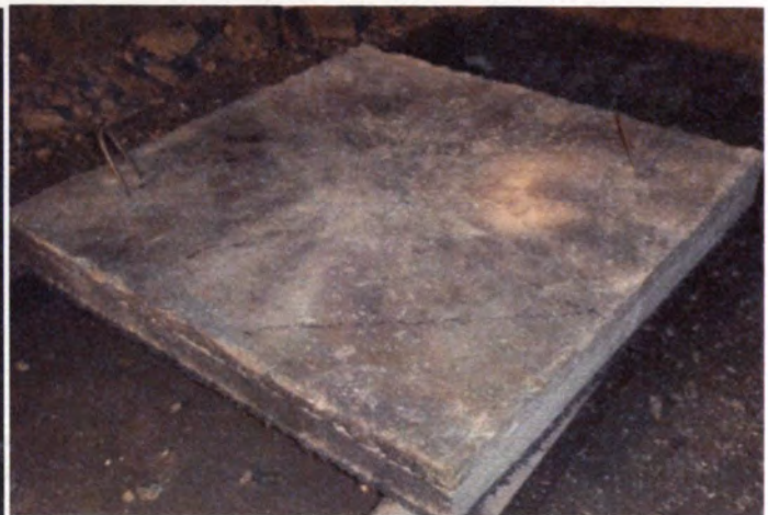
(d) Isometric View Cracks Outlined
