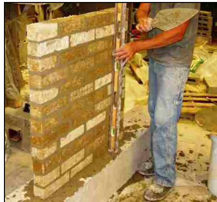
(d) Completed Wall
