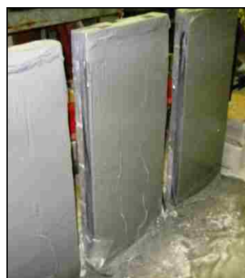
(d) Retrofitted URM Walls
