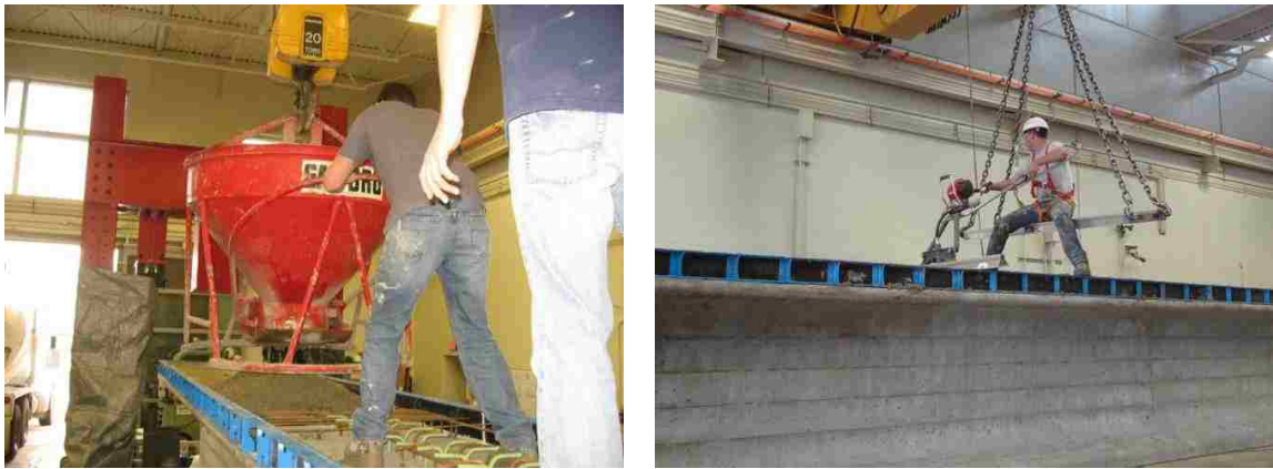
a) CIP Deck Pour
