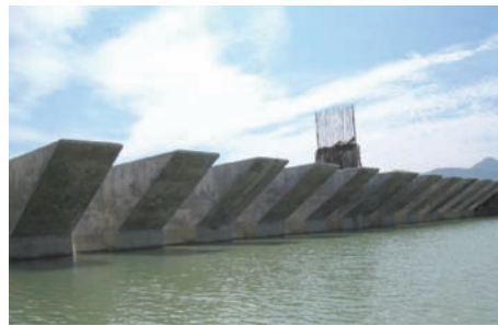
Fig. 3. The Van Phong PK Weir in Vietnam.
