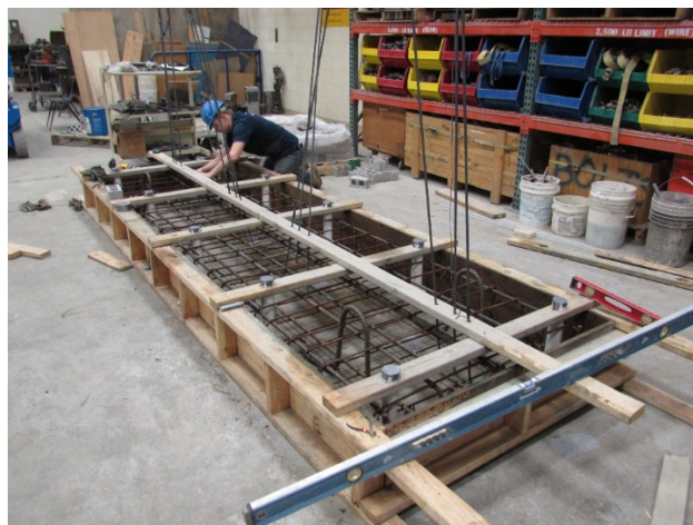
Figure 3-1: Foundation prior to pour
