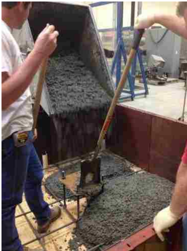
Figure 3-10: Footing Concrete Pour
