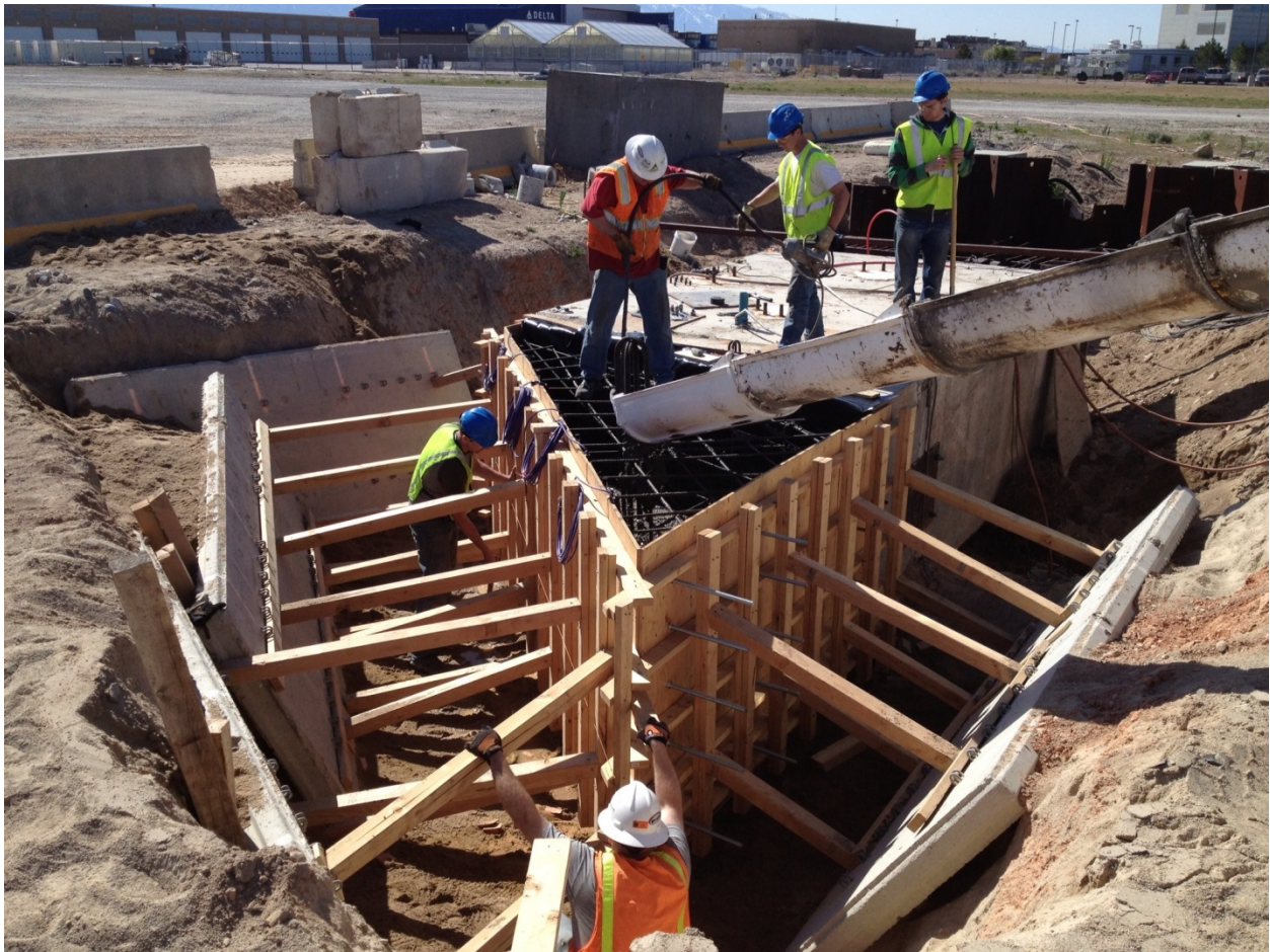
Figure 3.8. Concrete pour for 45° skew wedge.
