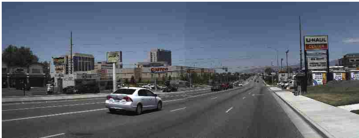
Figure 6-6: U.S. 89 in 2012 (UDOT 2013).
