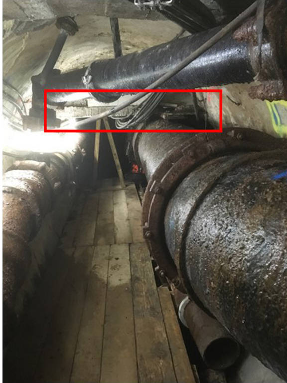
Fig. 11. Dalle de béton.
