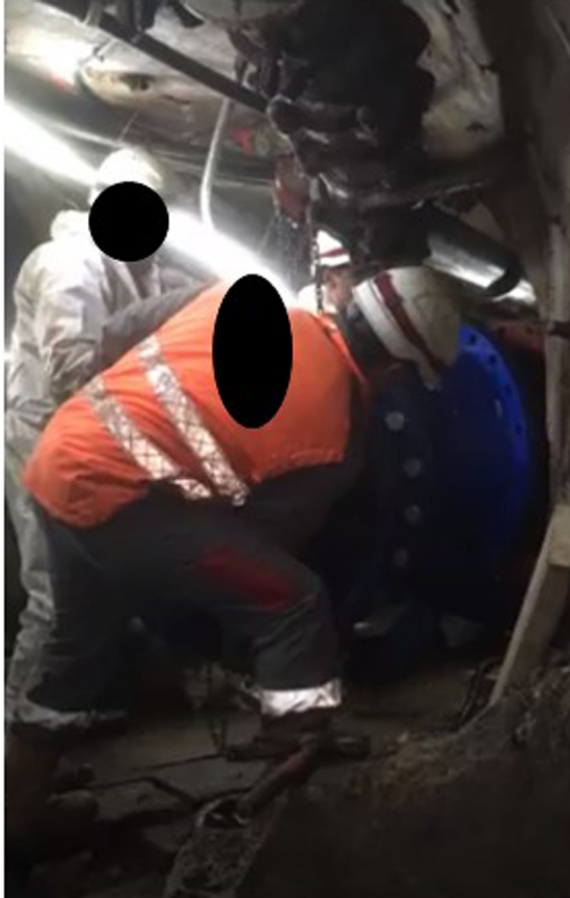
Fig. 7. Pose d'un coude.
