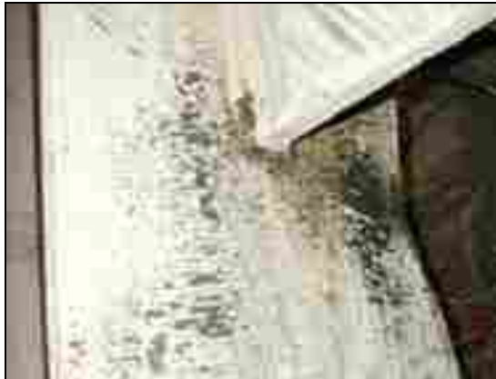
(d) Yielding and Warping of Column
