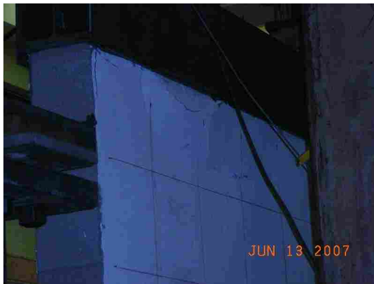
Top Course Crushing (wall #1)
