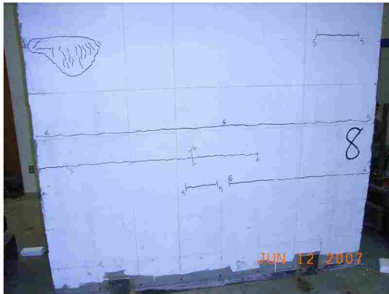
Horizontal Cracking (wall #8)
