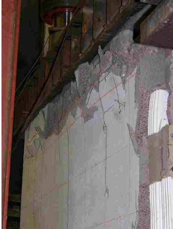
Top Course Crushing (wall #3)
