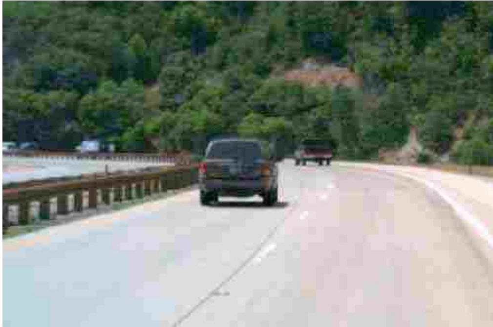
Figure 2-4. W-beam median barrier (UDOT 2008a).
